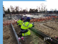
TRAVAUX PUBLICS : - Constructeur en Canalisations - Conducteur d'Engins - Constructeur de Routes
