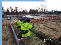
TRAVAUX PUBLICS : - Constructeur en Canalisations - Conducteur d'Engins - Constructeur de Routes
